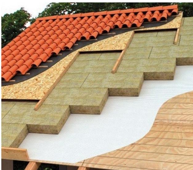
Per isolare bene la propria casa conviene optare per materiali con una bassa conducibilità termica ed elevato sfasamento termico, così da non avere dispersione di calore all'esterno durante l'inverno e ingresso di aria calda all'interno durante l'estate.
